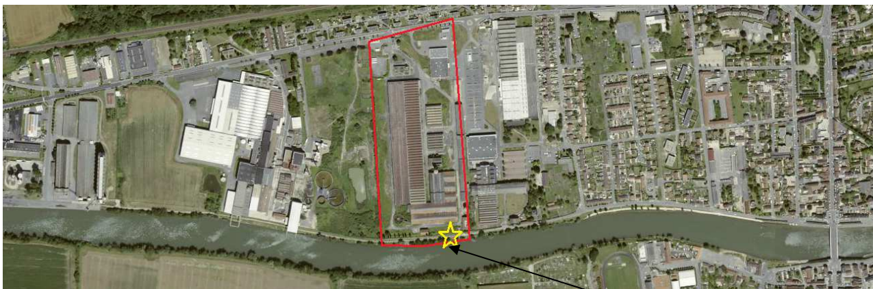
Emplacement de l'estacade actuelle
